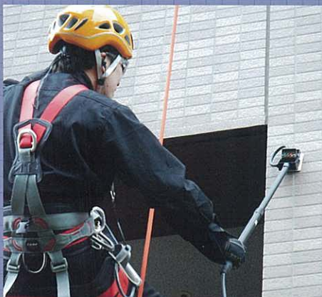
パワークイックとROBOハンマー併用による 外壁タイル打診調査風景 15階建・400戸 ○○○○マンション
