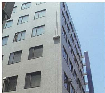
外壁診断ロボットによる 外壁タイル打診調査状況写真
